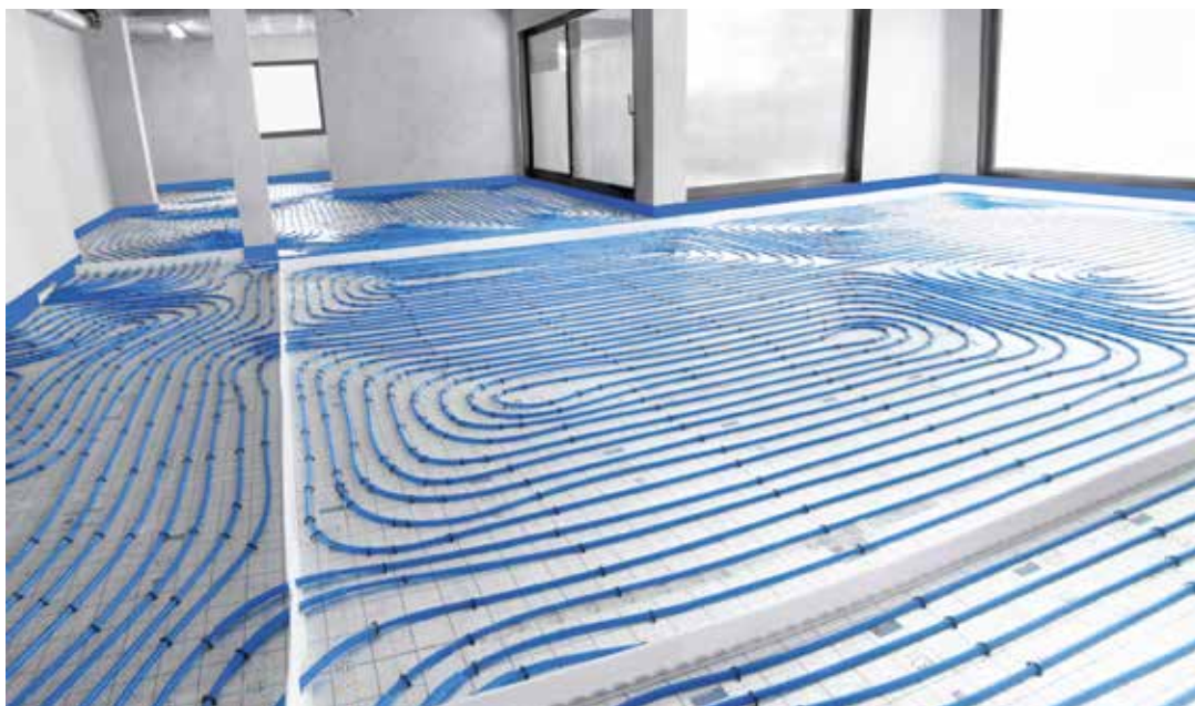
Joon. 25. Põrandaküte/-jahutus süsteemis KAN-therm Tacker.
