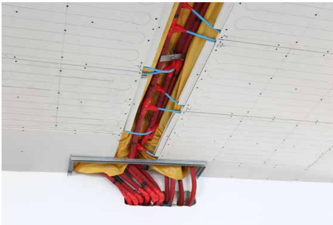
Joon. 6. Laejahutussüsteem, milles kasutatakse süsteemi KAN-therm Wall kütte- ja jahutusplaate.
