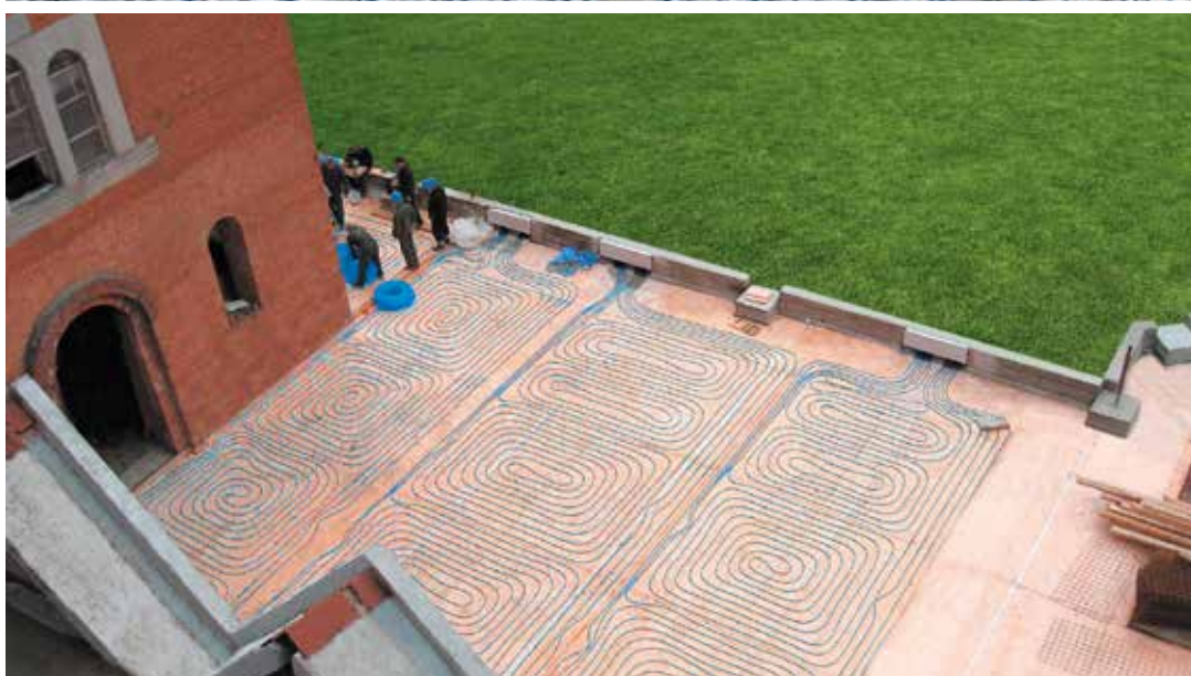
Joon. 5. Väliterrassi küttesüsteemis, milles kasutatakse KAN-therm süsteemi blueFLOOR PERT torusid.
